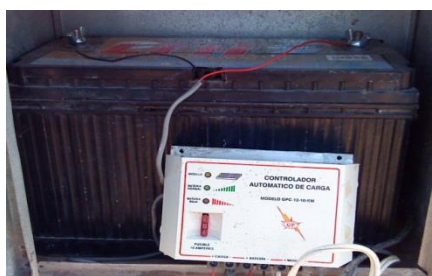
Figura 6.7. Batería LTH con rejillas "Rounded Corner" para proporcionar la energía.
